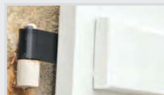
PLIAGE DES PENTURES : adaptation aux gonds existants
