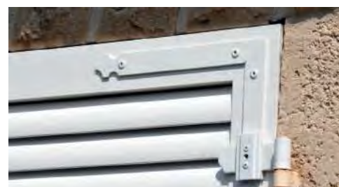
LE FERRAGE RÉNOVATION
